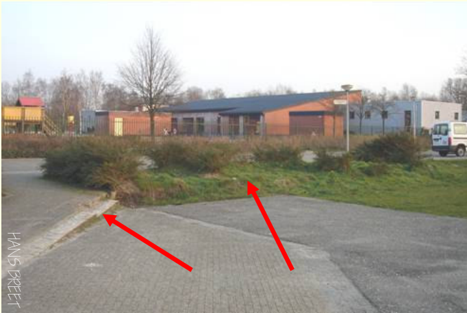
AFGEBROKEN MUURTJE EN VERWILDERD GROEN
